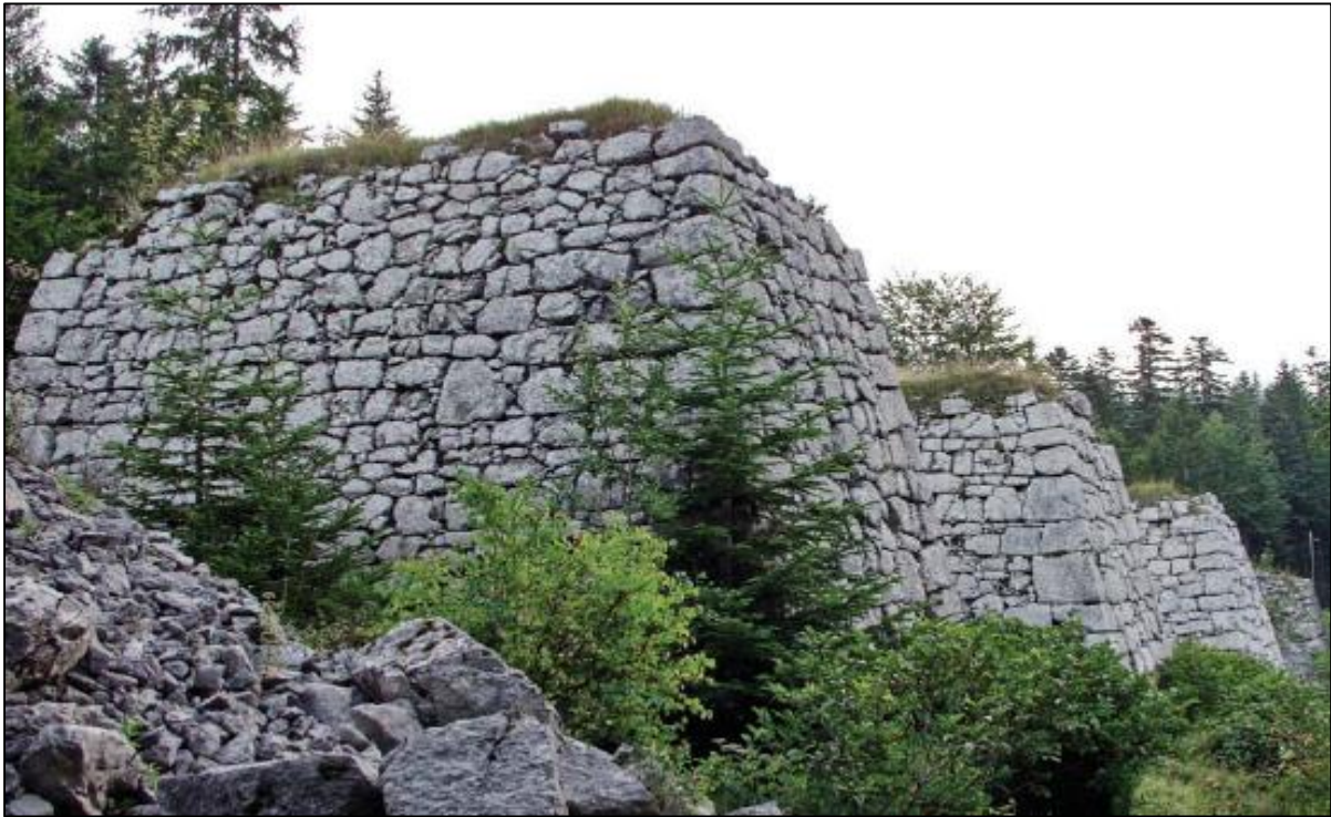
Slika 7: Kameni potpornji mosta na trasi Karolinske cesti.
