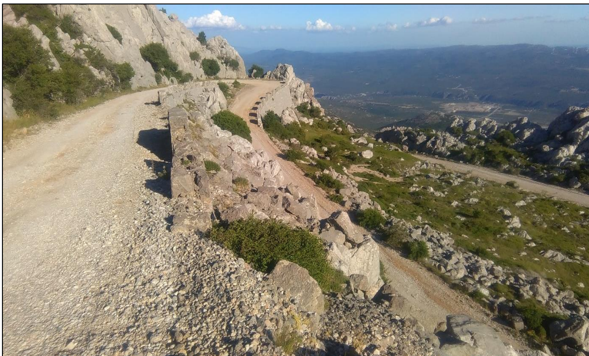
Slika 17. Majstorska cesta ispod Tulovih greda
