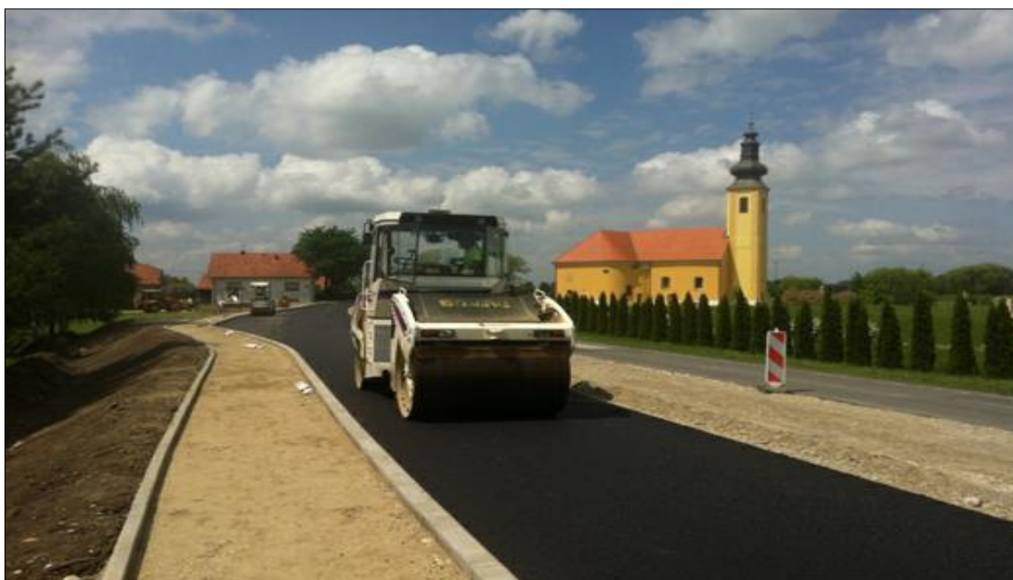
Slika 8. Izvanredno održavanje ceste DC20 (Sv. Križ – Prelog)
