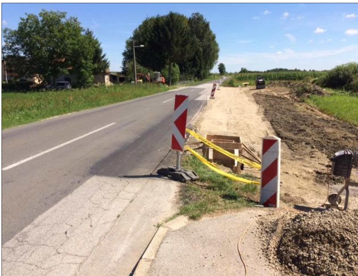
Slika 22. Radovi uz ŽC2005
