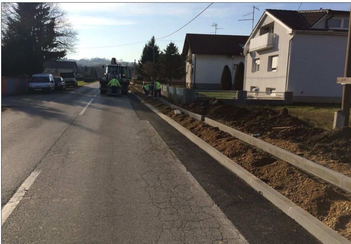
Slika 26. Radovi na ŽC 2006 u Selnici
