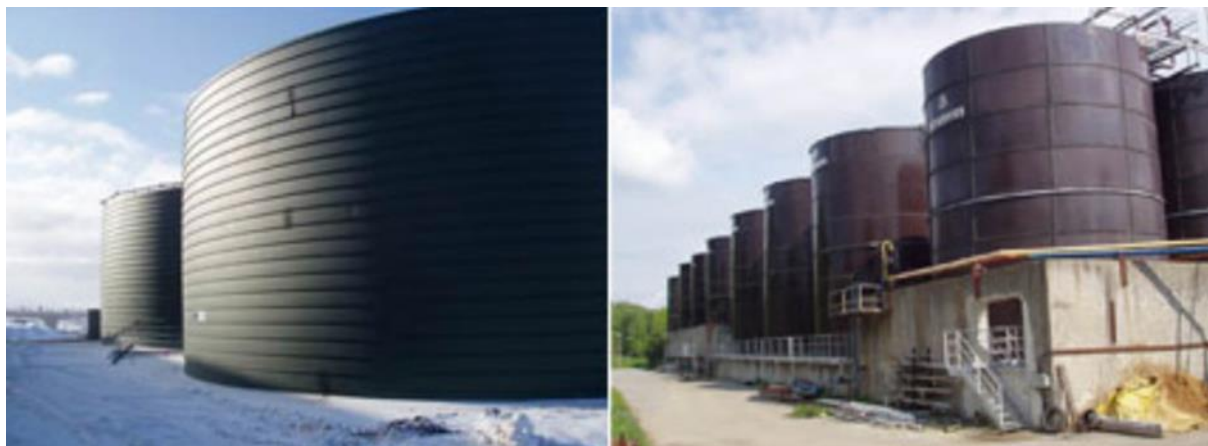
Slika 5. Čelici i betonski digrestor.
