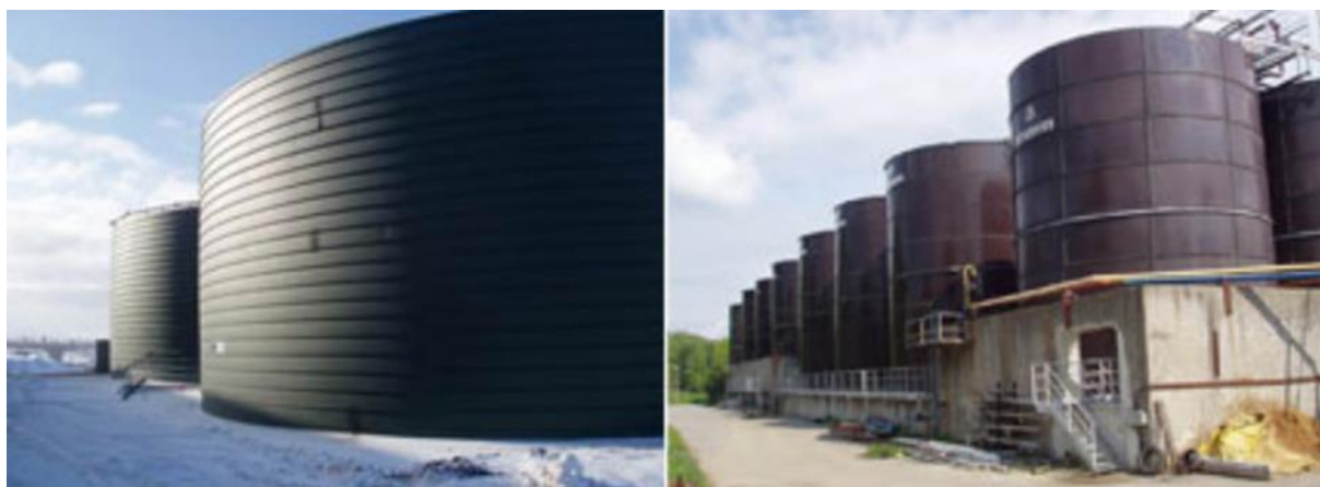
Slika 5. Čelici i betonski digrestor.
