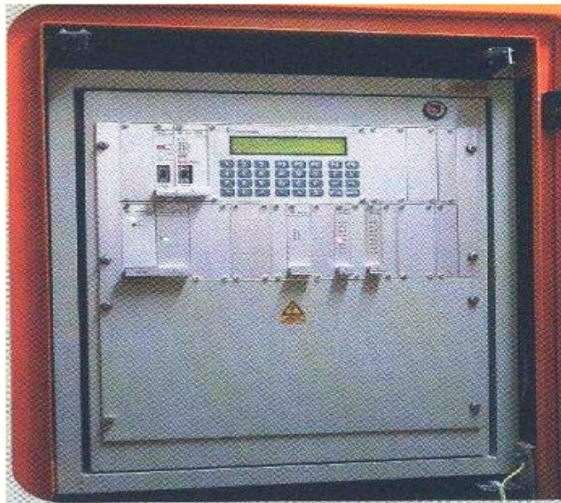
Slika 8: Cestovna prometna stanica
