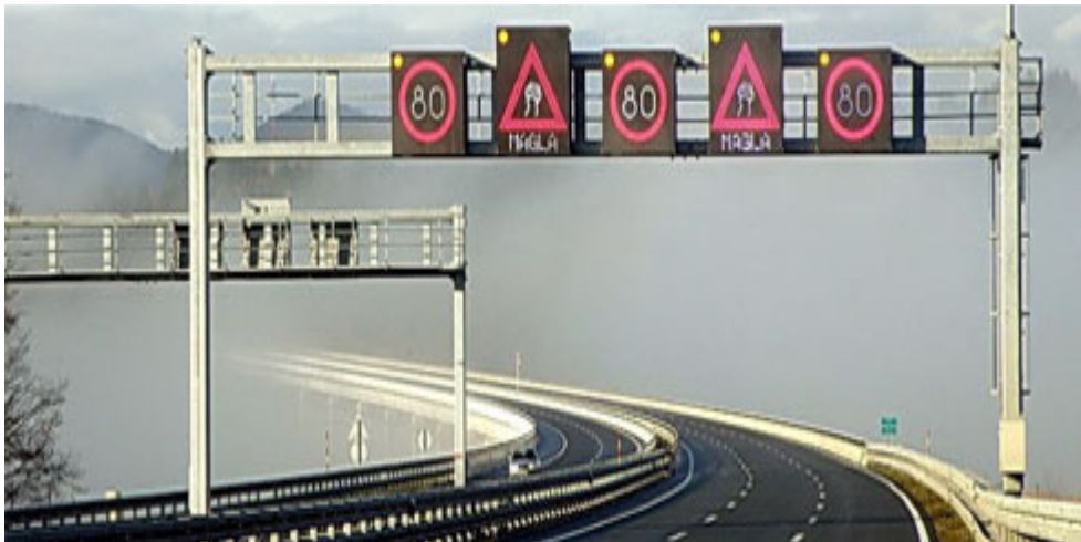
Slika 11. Promjenjiva prometna signalizacija
