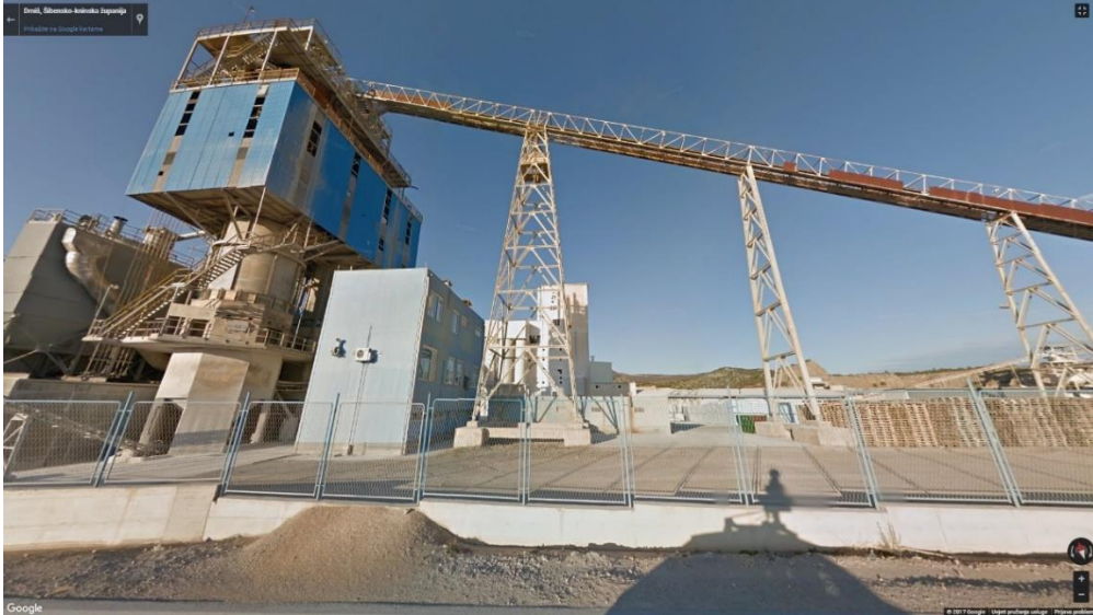
Slika 22. Prijenos minerala kosim trakastim transporterom u peć
