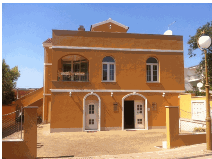
Slika 22 Postavljanje građevinske stolarije na gotov objekt, Izvor: http://sibenik-aluminij.com/
