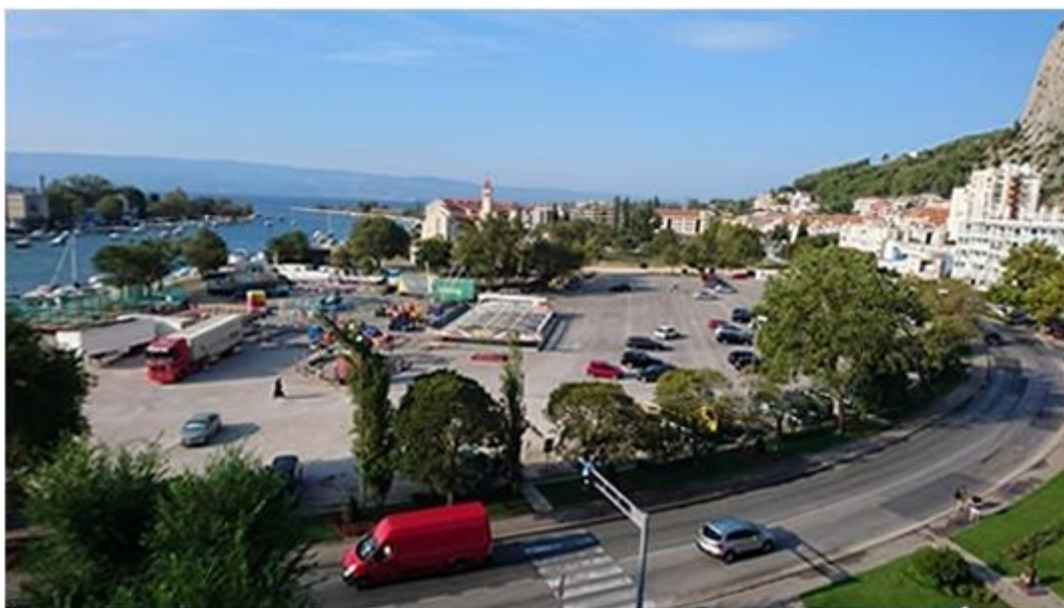
Slika 5. Parking s rampom na Priku
