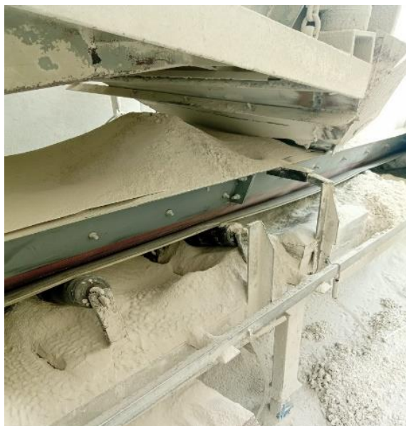
Slika 26. Transport vapna trakastim transporterom
