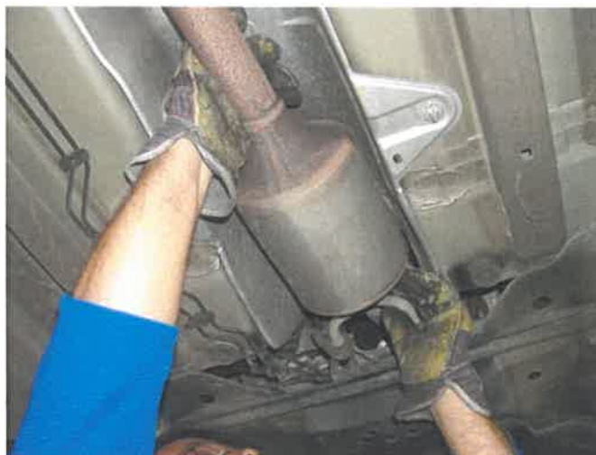
Slika 8. Provjera učvršćenosti ispušnog sustava
