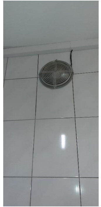
Slika 11 Umjetna ventilacija
