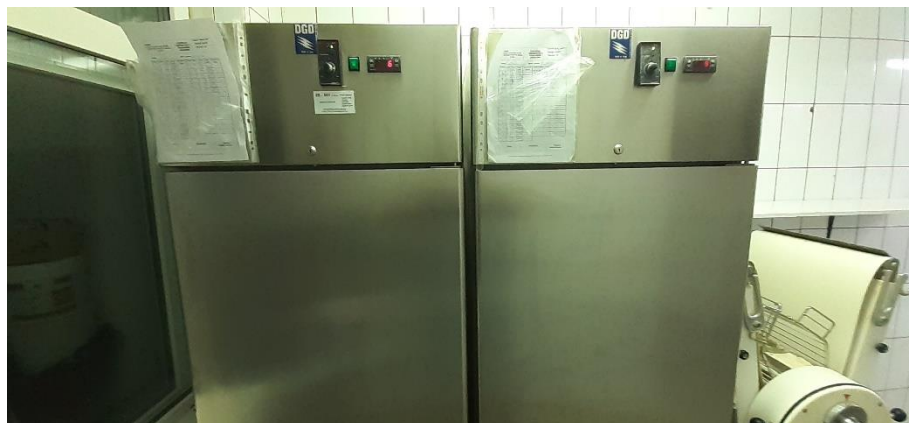
Slika 37 Prikaz rashladnih uređaja sa kontrolnim uređajima za temperaturu, te evidencijom temperature
