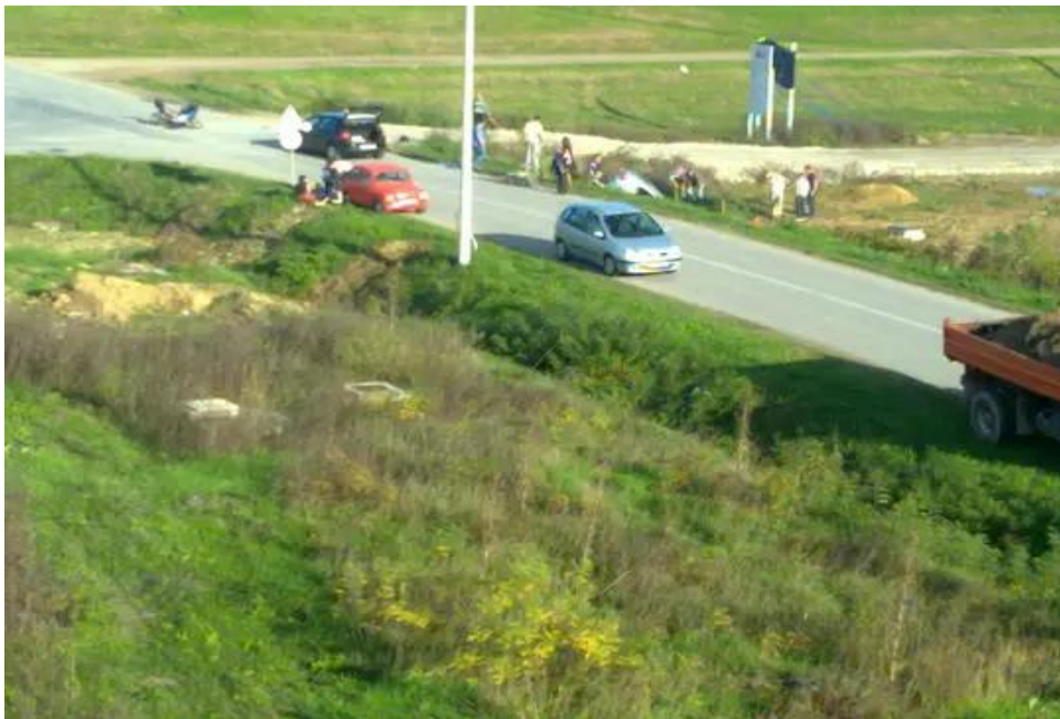
Slika 24 Stanje raskrižja prije rekonstrukcije
