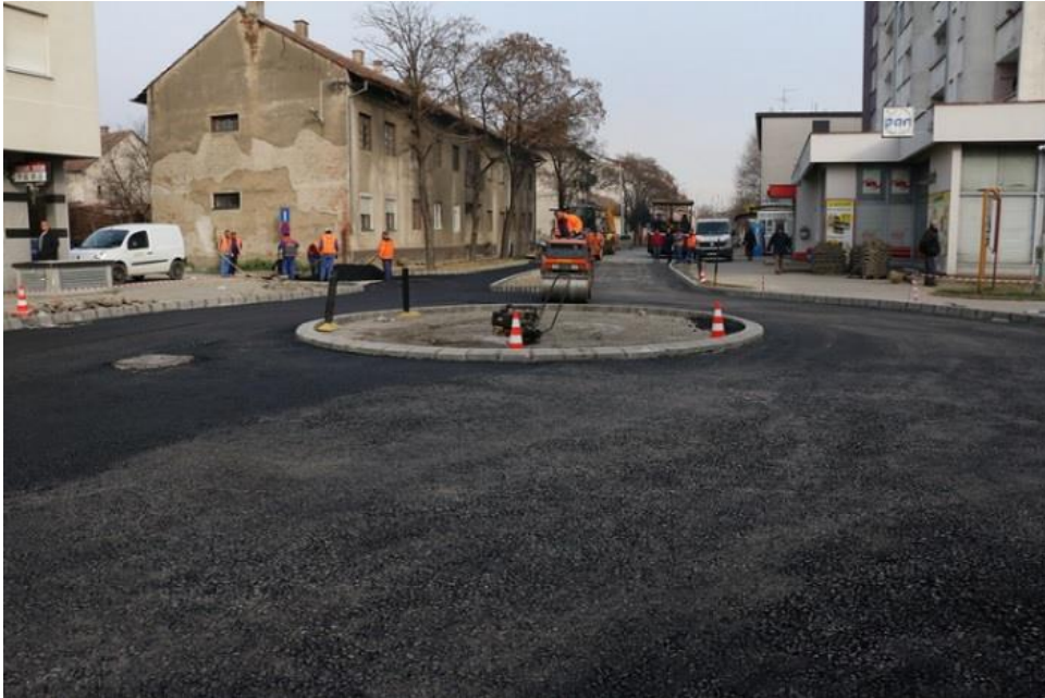
Slika 23 Postavljen novi sloj asfalta na rekonstruiranom raskrižju ž
