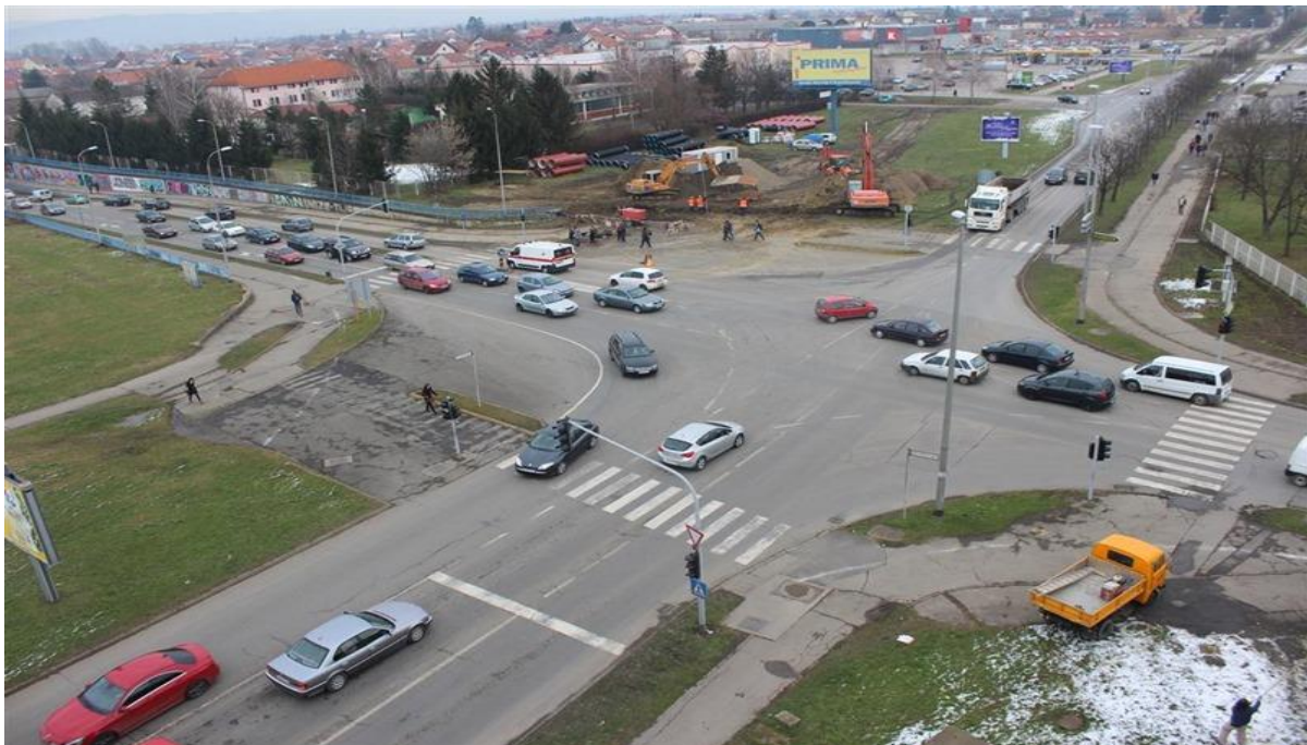
Slika 3 Stanje raskrižja prije rekonstrukcije
