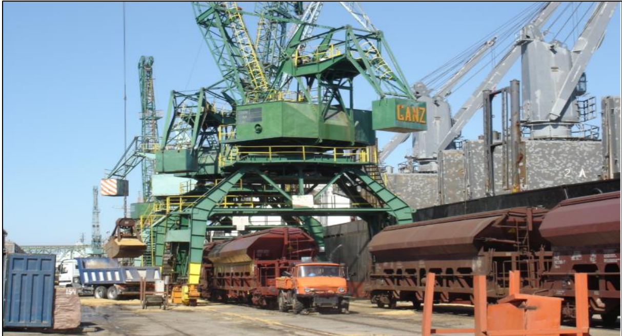
Slika 3. Terminal za rasuti teret luke Split
