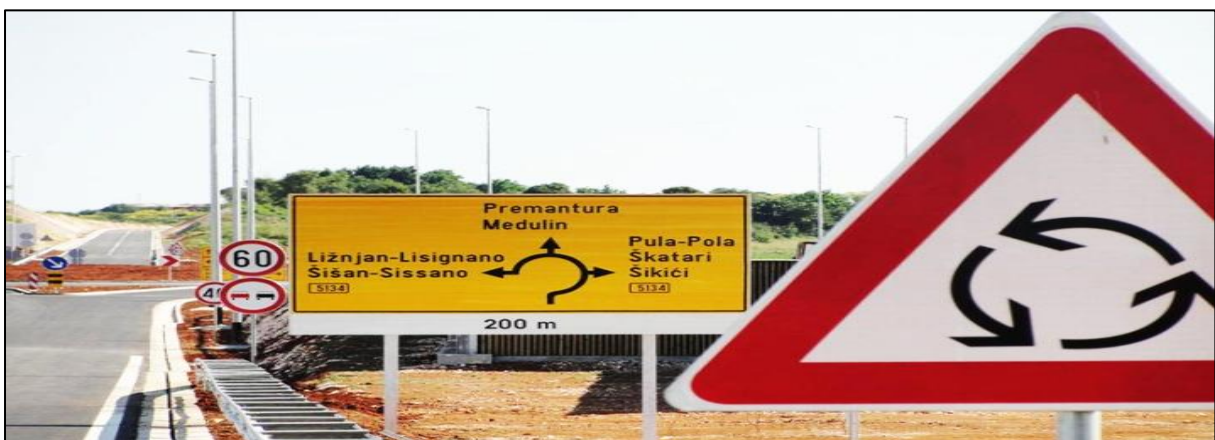
Slika 8. Primjer vertikalne signalizacije
