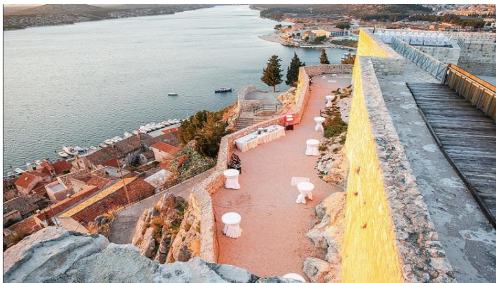
Slika 4. Tvrđava sv.Mihovila nakon obnove
