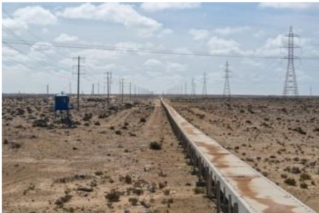
Slika 2. Najduži trakasti transporter na svijetu (100km), Zapadna Sahara
