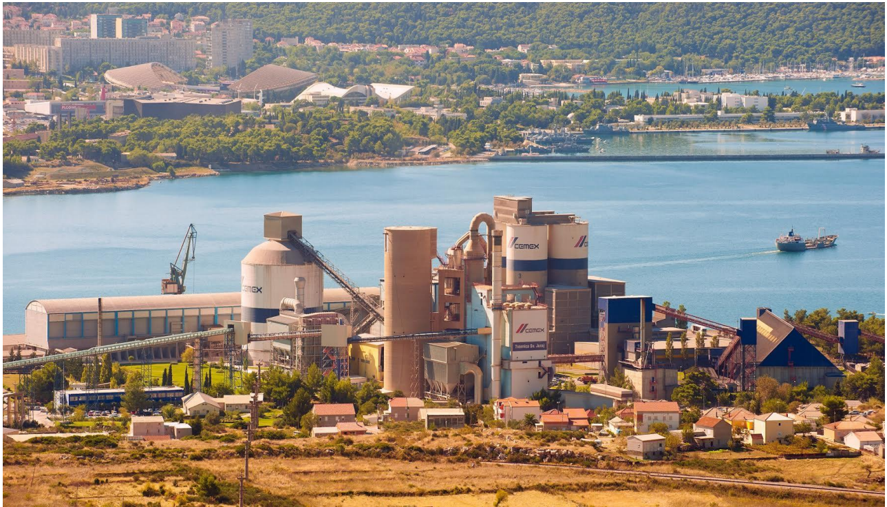
Slika 19. CEMEX – Tvornica Sveti Juraj Kaštel Sućurac
