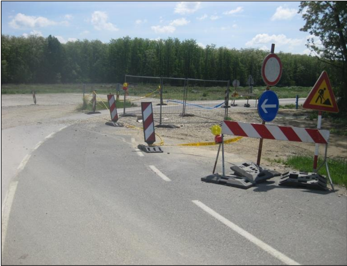
Slika 28. Izvanredno održavanje ceste
