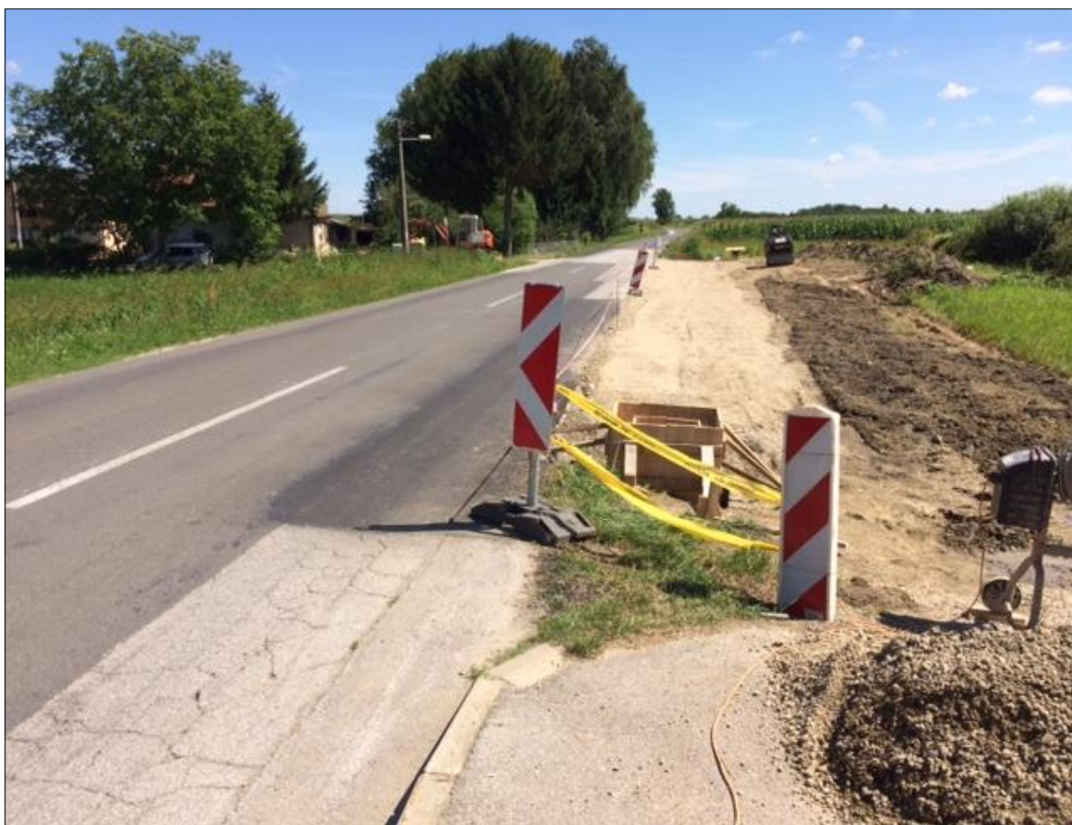
Slika 22. Radovi uz ŽC2005
