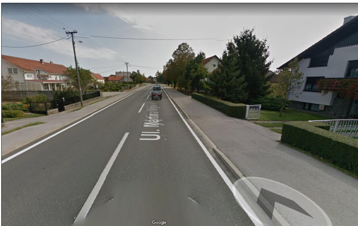
Slika 12. Stanje ceste DC208 u Nedelišću
