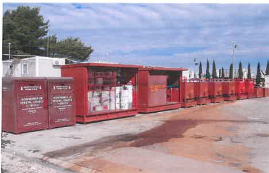
Slika 6. Reciklažno dvorište na odlagalištu otpada Diklo
