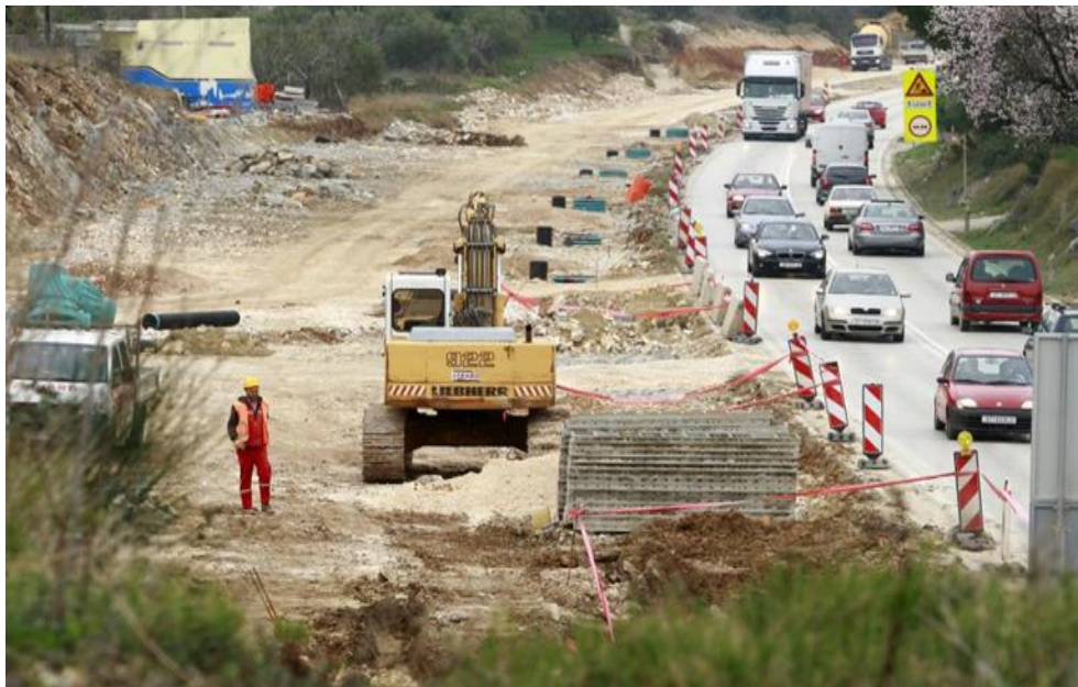
Slika 13. Gradnja brze ceste kroz Kaštela
