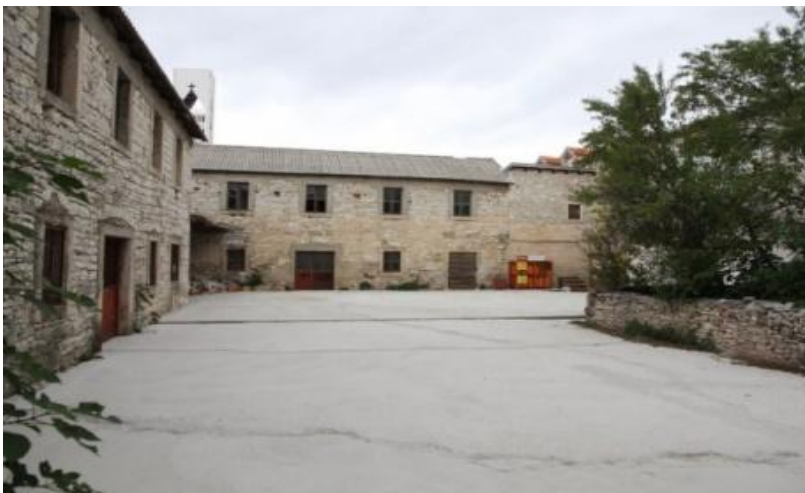
Slika 36: Zgrada budućeg centra za posjetitelje NP“Krka“ u Kistanjama
