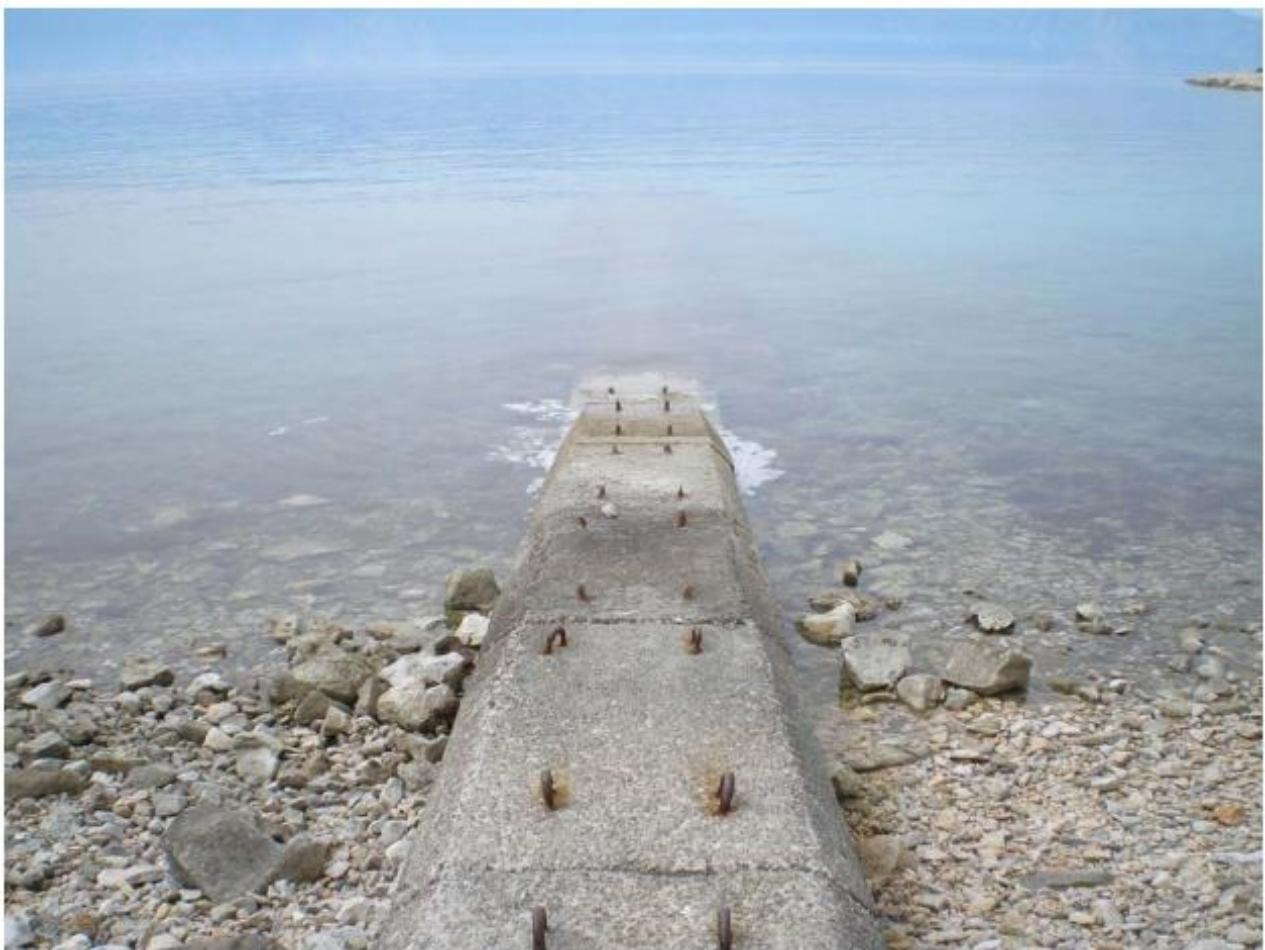
Slika 17. Primjer priobalne zaštite 110kV podmorskog kabela
