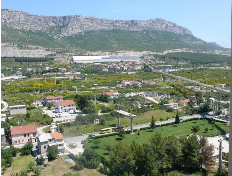
Slika 19. CEMEX-ov trakasti transporter na uzvišenoj metalnoj konstrukciji
