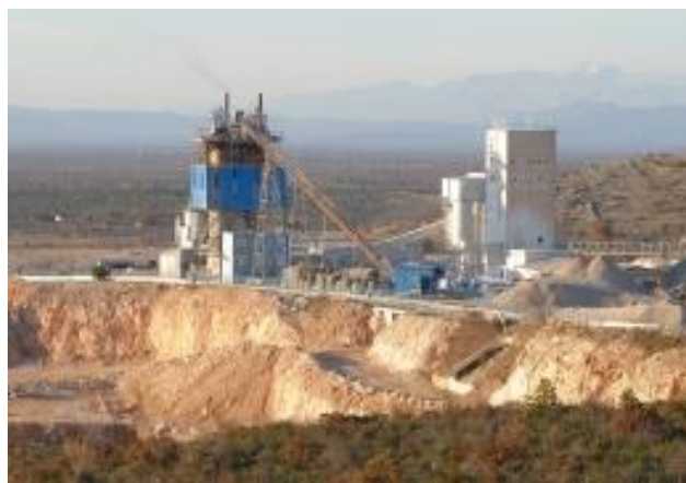
Slika 21. Postrojenje girk Kaluna
