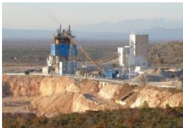
Slika 21. Postrojenje girk Kaluna
