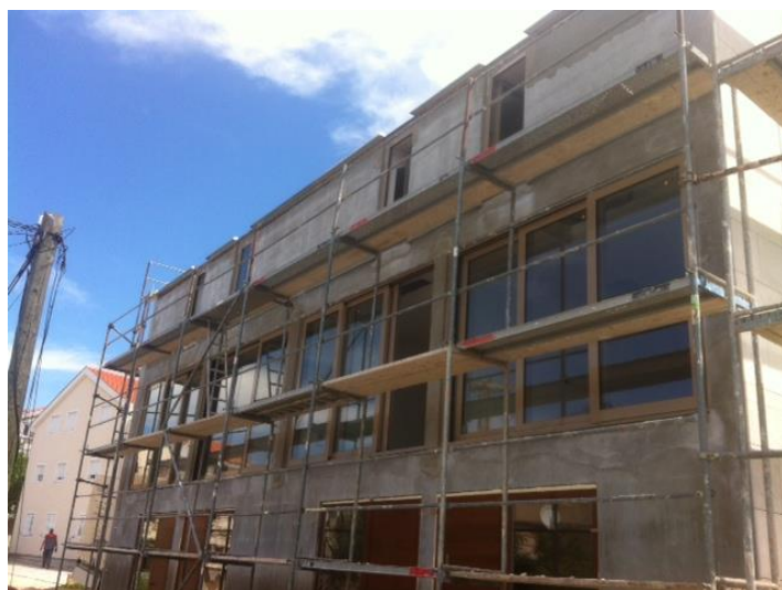
Slika 21 Primjer ugradnje građevinske stolarije na objekt u izgradnji, Izvor: http://sibenik-aluminij.com/
