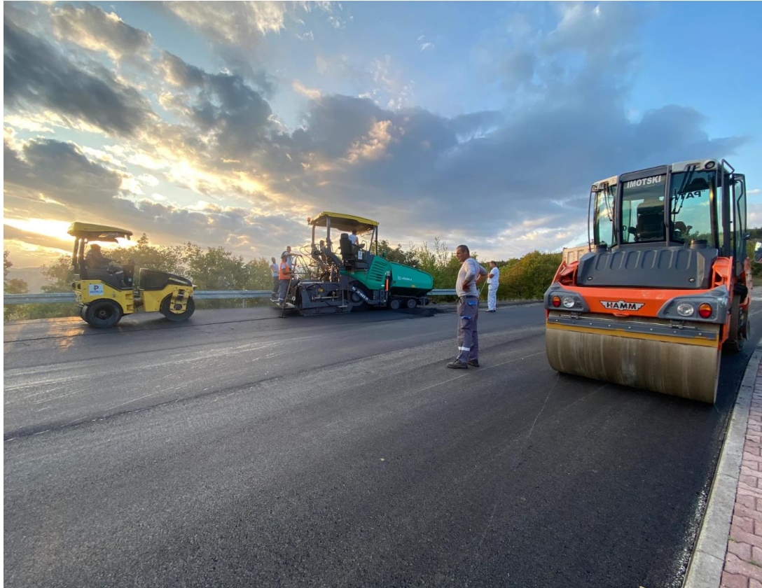
Slika 20. Asfaltiranje Izvor: https://www.patrlji.hr/ (Preuzeto: 2.8.2022.)
