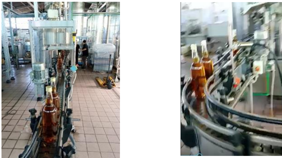
Slika 22. Horizontalni člankasti transporter s metalnom trakom pravocrtnog gibanja (lijevo) i zakrivljenog gibanja (desno) Izvor: Osobna izrada autora (29. 8. 2022.)
