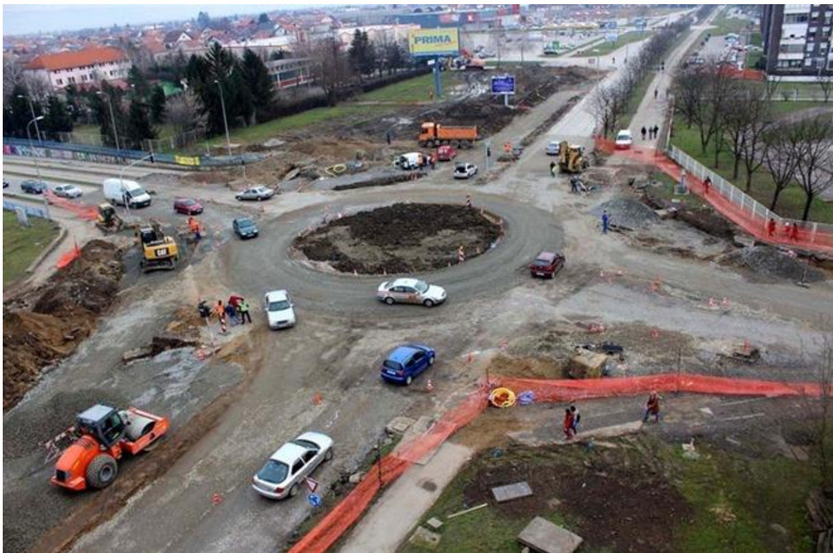
Slika 4 Izgradnja kružnog raskrižja
