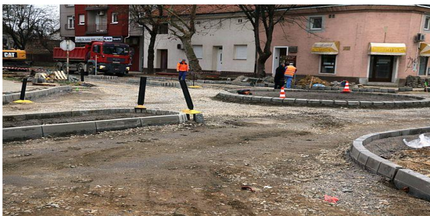
Slika 20. Prikaz raskrižja tijekom radova
