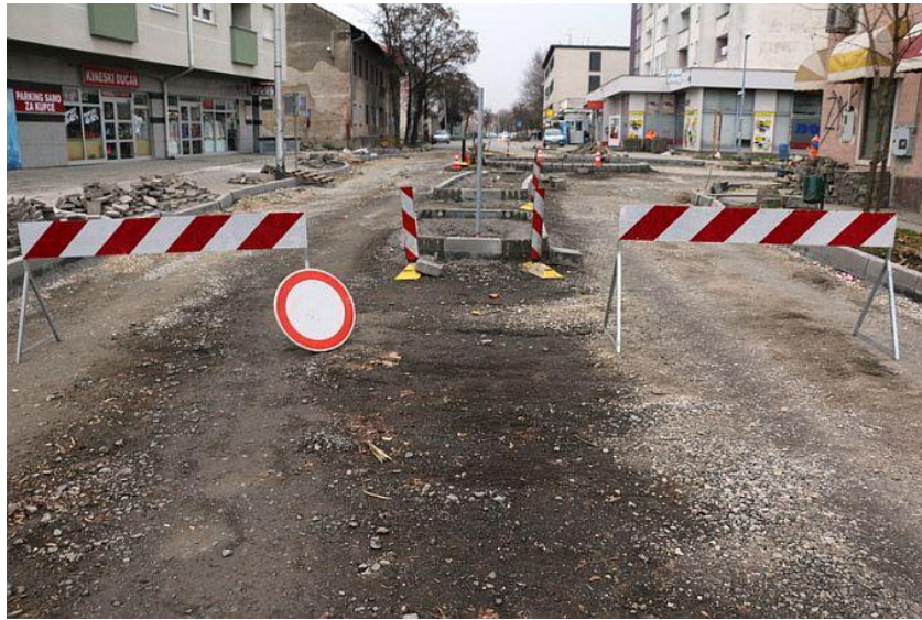
Slika 21. Privremena zabrana prolaza kroz raskrižje zbog rekonstrukcije
