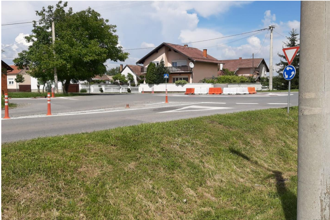
Slika 30 Prilaz u raskrižje iz smjera zapada
