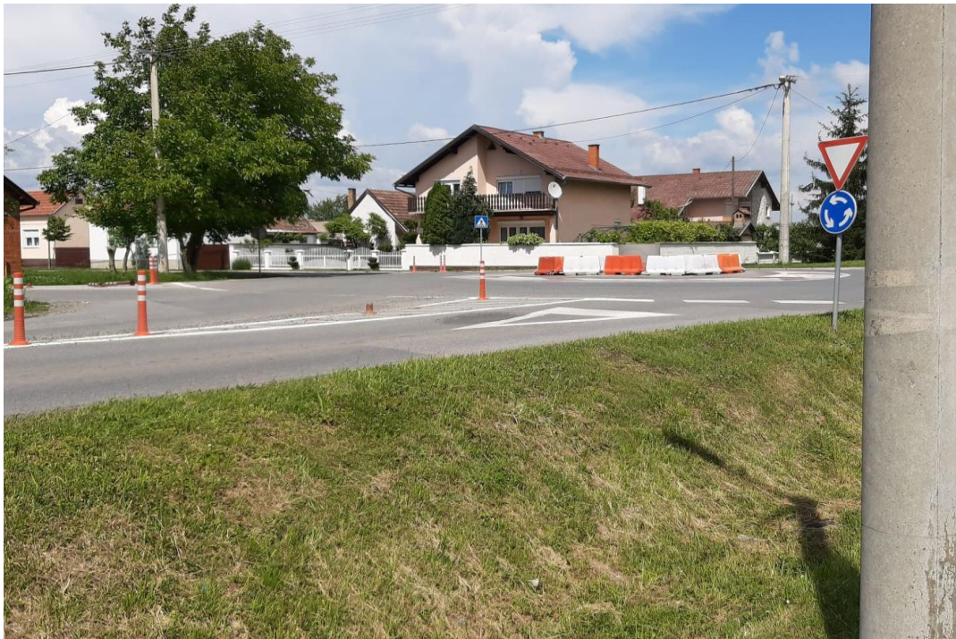
Slika 30 Prilaz u raskrižje iz smjera zapada
