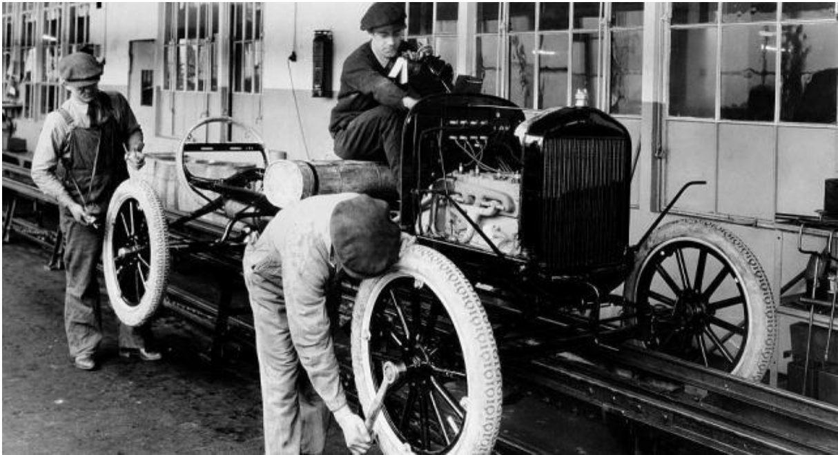
Slika 3. Montažna transportna traka Fordova automobila Model-T
