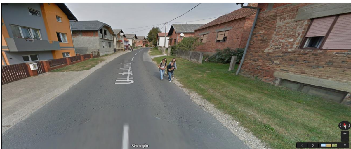
Slika 17. Smanjena sigurnost pješaka na ŽC2008
