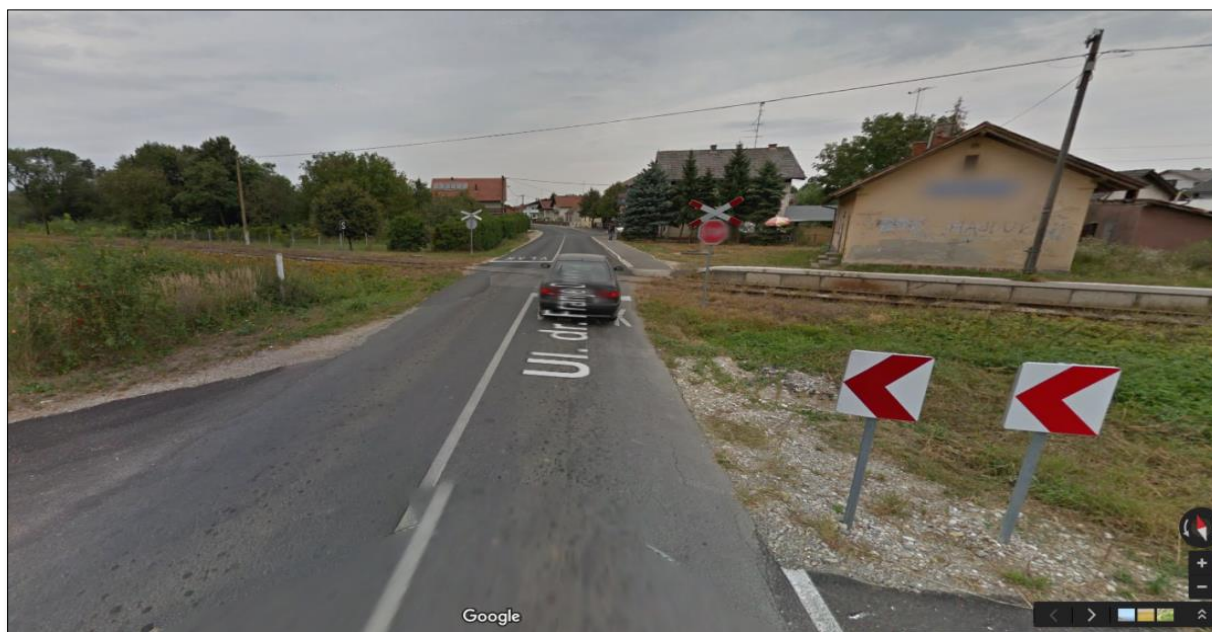
Slika 18. Križanje ŽC 2008 (Vratišinec) sa željezničkom prugom
