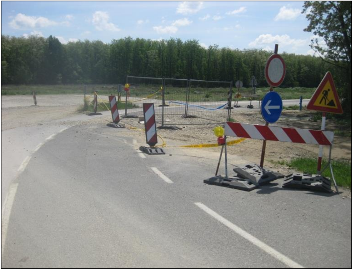
Slika 28. Izvanredno održavanje ceste
