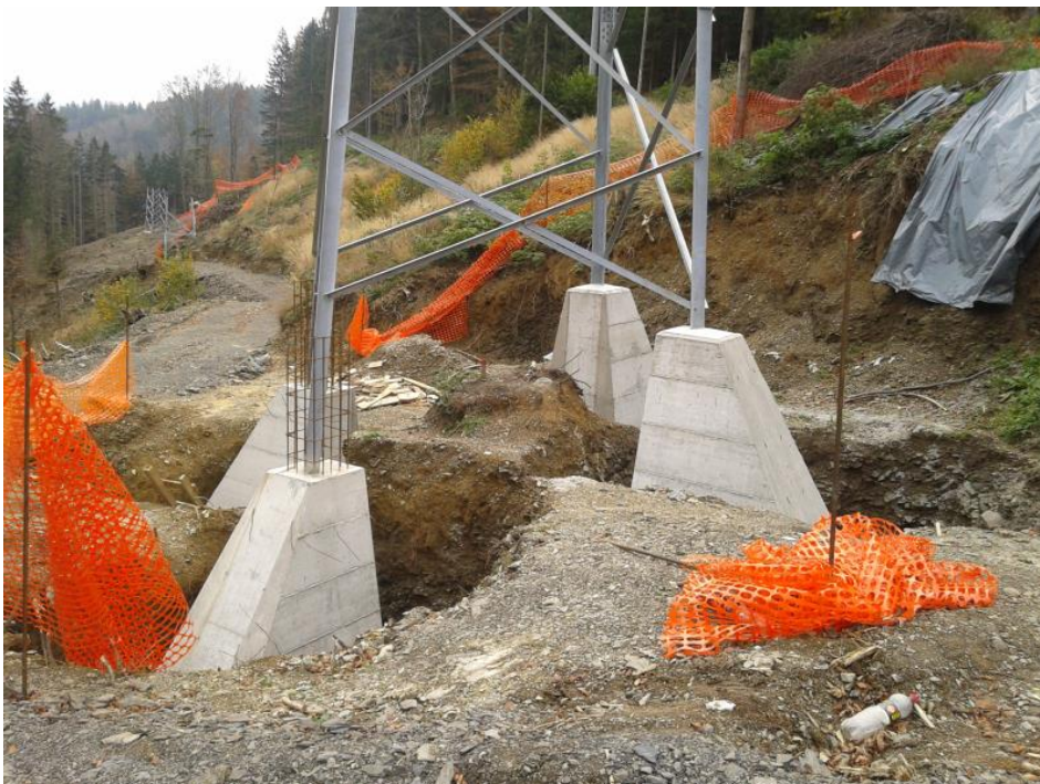
Slika 21. Izgradnja temelja
