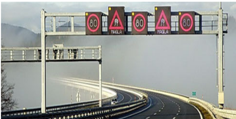
Slika 11. Promjenjiva prometna signalizacija
