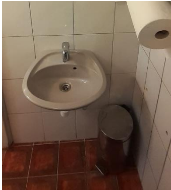
Slika 30 Kanta za smeće u zahodskoj kabini
