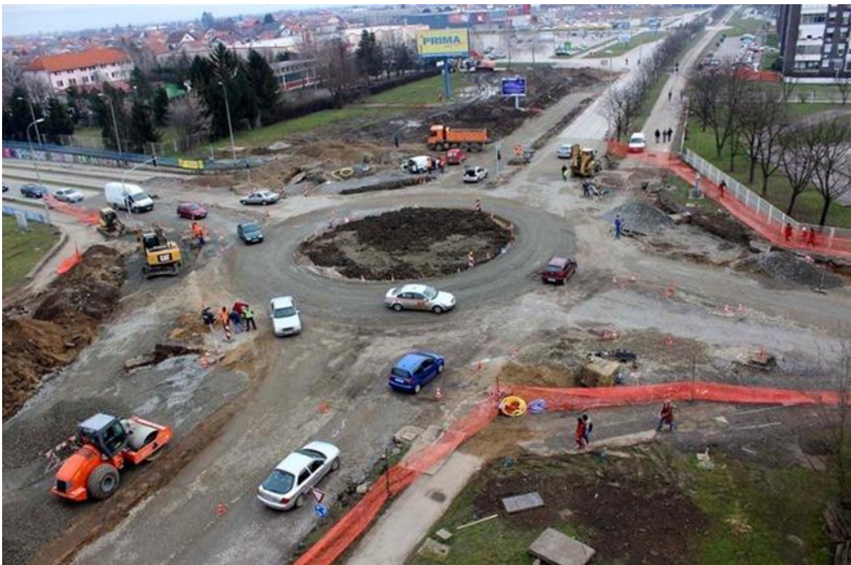
Slika 4 Izgradnja kružnog raskrižja
