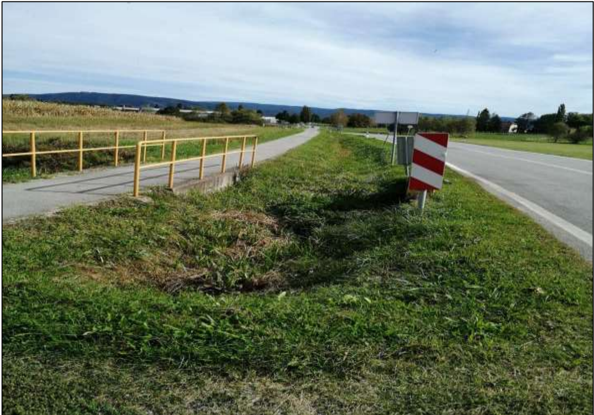
Slika 10. Prikaz zemljanih banikina dionice Lipik – Dobrovac
