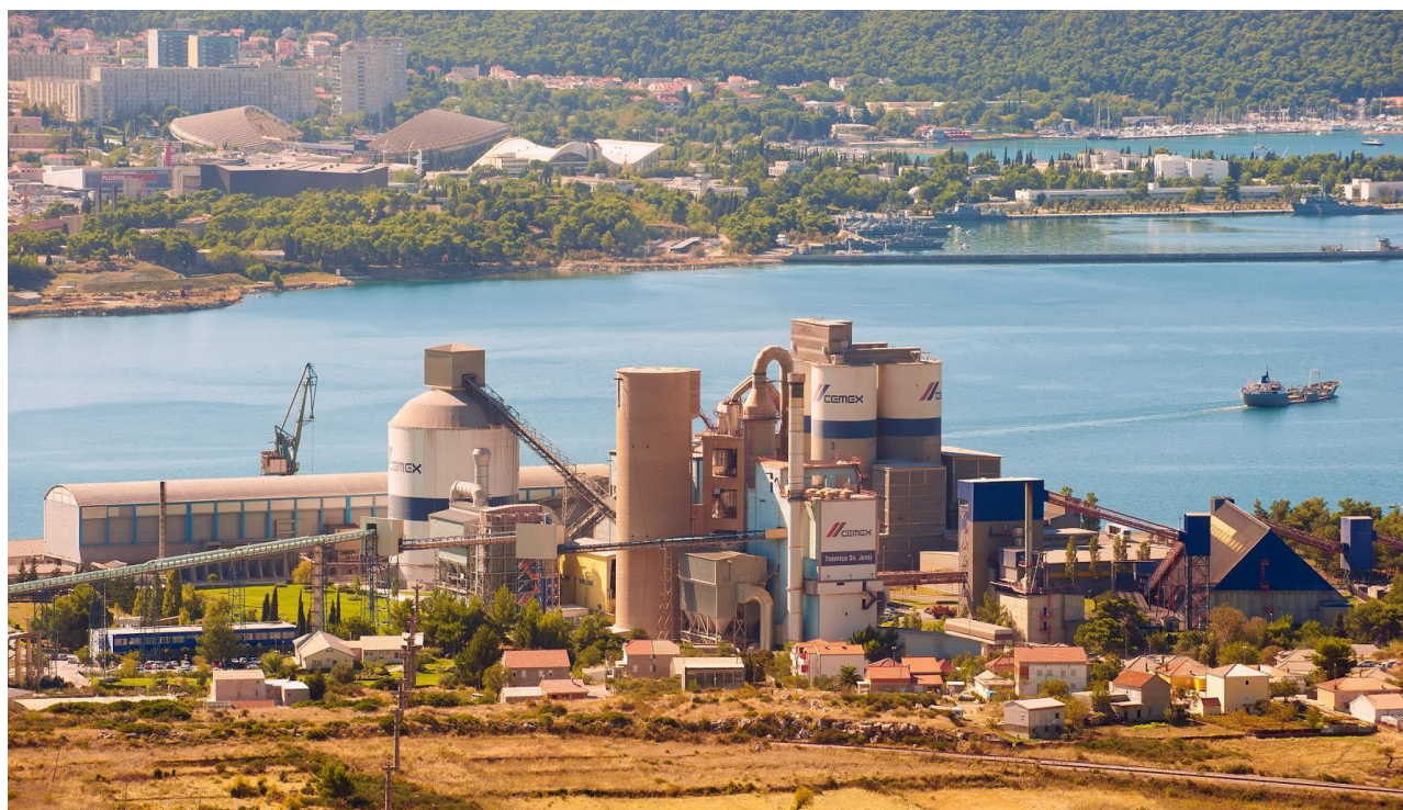
Slika 19. CEMEX – Tvornica Sveti Juraj Kaštel Sućurac
